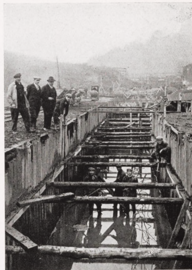
Fig. 85. Fouille inondée de fondation de l'Institut de Chimie et de Métallurgie au Val Benoît.
