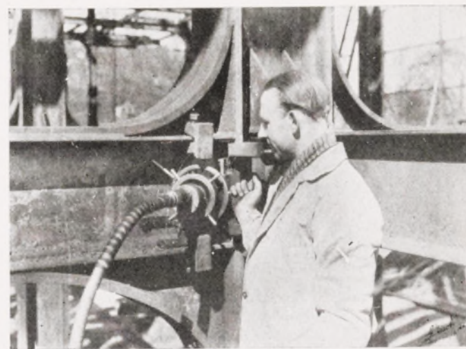
Fig. 91. Contrôle d'un cordon de soudure au chantier.
