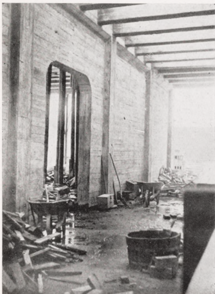
Fig. 96. Vue de la poutre en béton armé après décoffrage.
